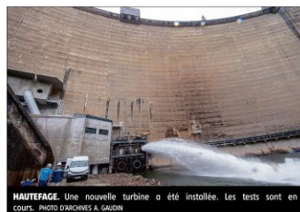
HAUTEFFAGE. Une nouvelle turbine a été installée. Les tests sont en cours. PHOTO D'ARCHIVES A. GAUDIN
