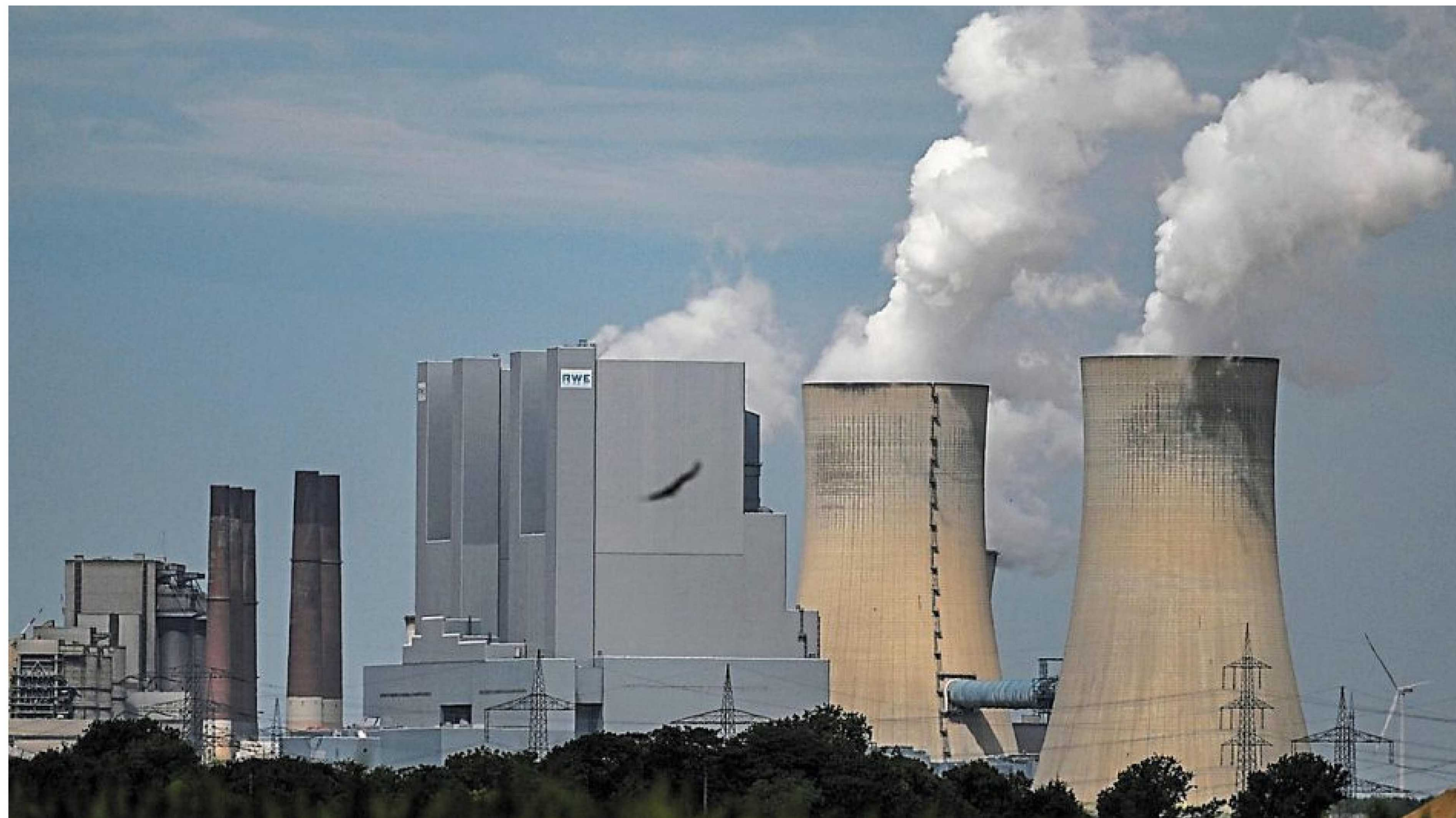
Le gros exploitant allemand RWE a fermé la grande centrale à charbon de Neurath, dans le bassin rhénan, fin mars.
