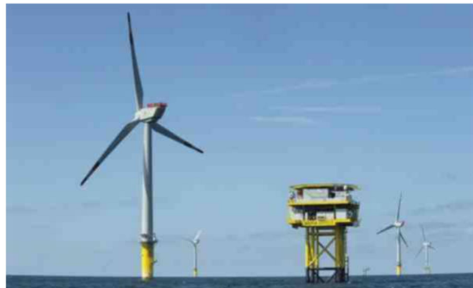
Le câble qui amènera à terre la production du parc éolien en mer d'Oléron partira d'une sous-station électrique de ce genre. AFP
