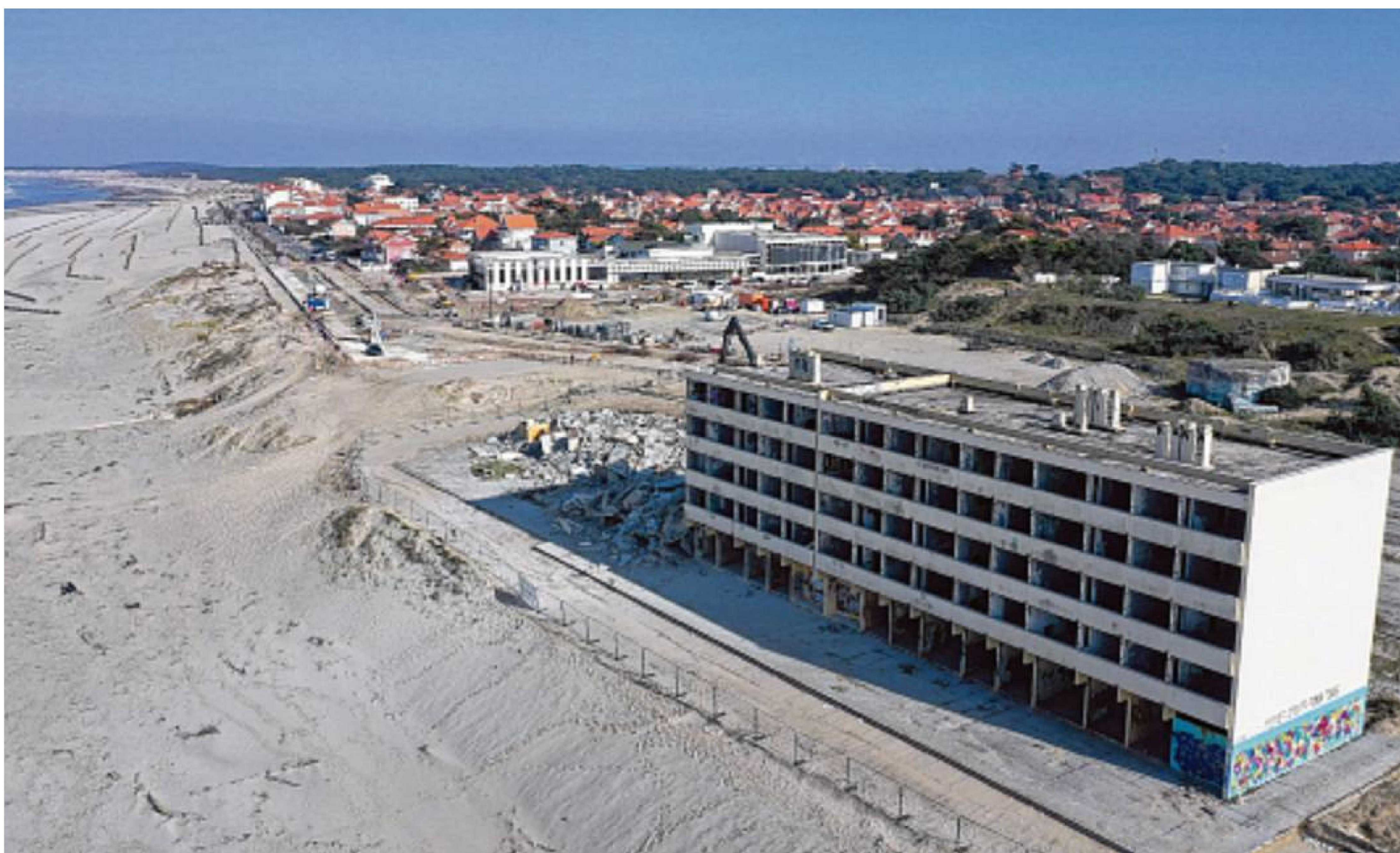
Dans son scénario 2050, "vraisemblable" selon le Cerema, 5 200 logements d'une valeur estimée à 1,1 milliard d'euros, dont 2 000 résidences secondaires, ainsi que 1 400 locaux d'activités, seraient sous les eaux. Ici, la démolition d'une résidence menacée par l'érosion en Gironde. /PHOTO ILLUSTRATION MAXPPP
