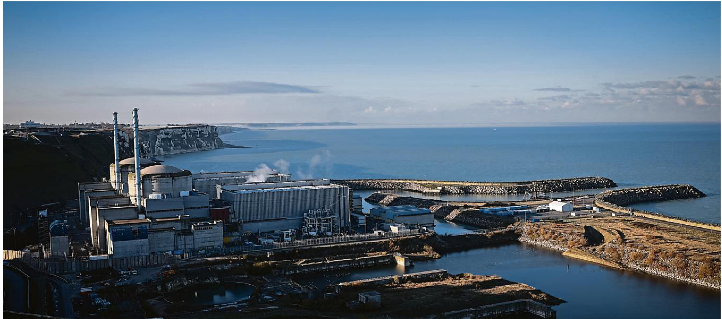
Le chantier, situé sur le littoral de Seine-Maritime, devrait démarrer cet été et durer un peu plus de trois ans. Photo Lou Benoist/AFP
