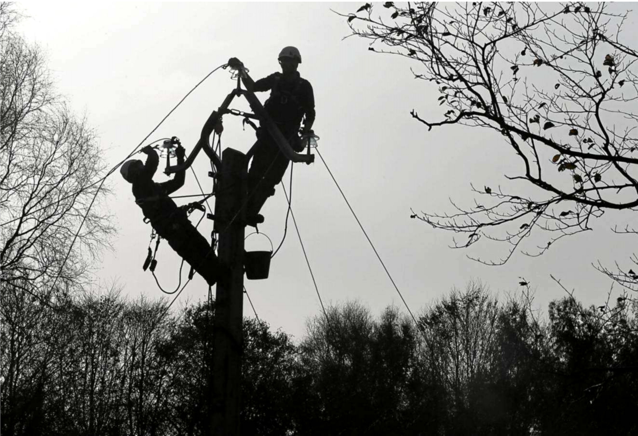
Des techniciens d’Enedis intervenant sur une ligne endommagée par la tempête Ciaran. Face aux tempêtes, l’enfouissement des réseaux apparaît comme une solution, mais ne comporte pas que des avantages. Photo d’archives Lionel Le Saux
