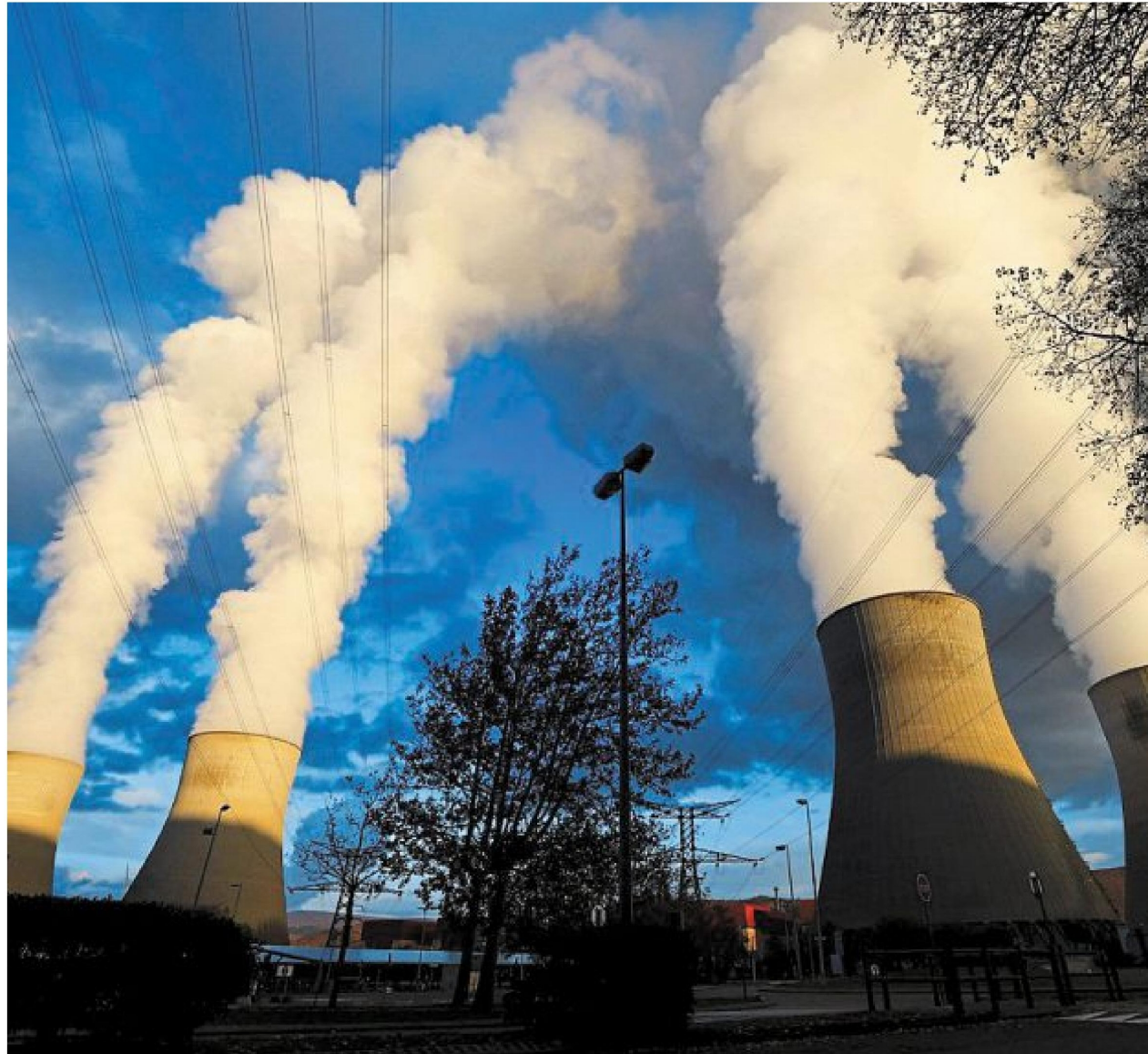
La centrale nucléaire de Cruas-Meysses (Ardèche), en novembre 2021.
