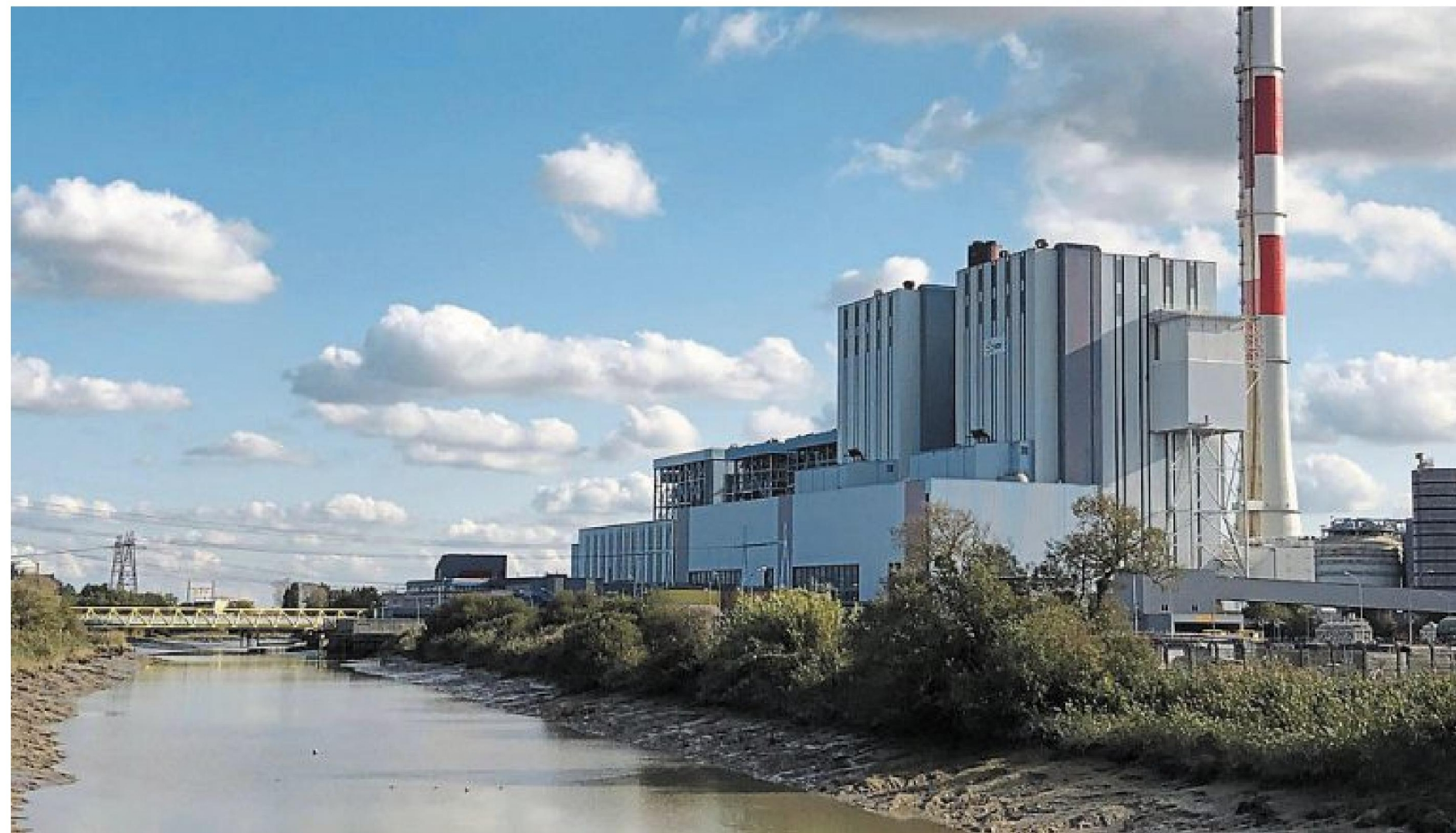
Un troisième comité de suivi sur l'avenir de la centrale électrique de Cordemais a été organisé en préfecture de Nantes le 15 novembre 2024.
