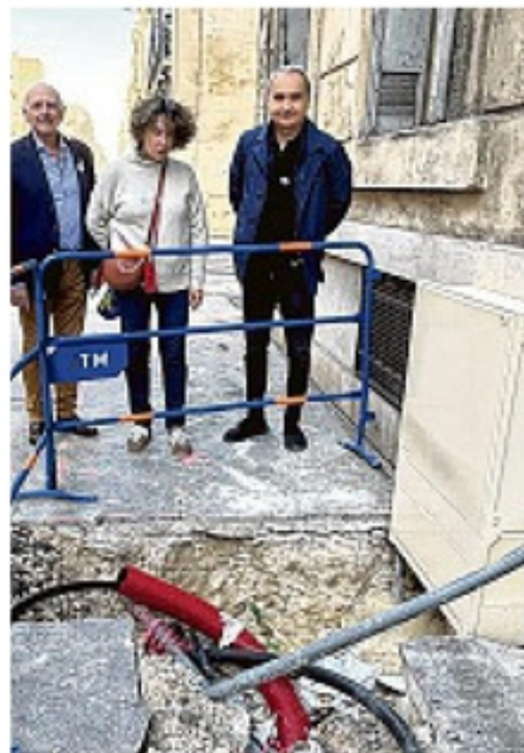
Le CIQ Périer inspecte le chantier d'installation des coffres électriques d'Enedis. / PHOTO N.P.
