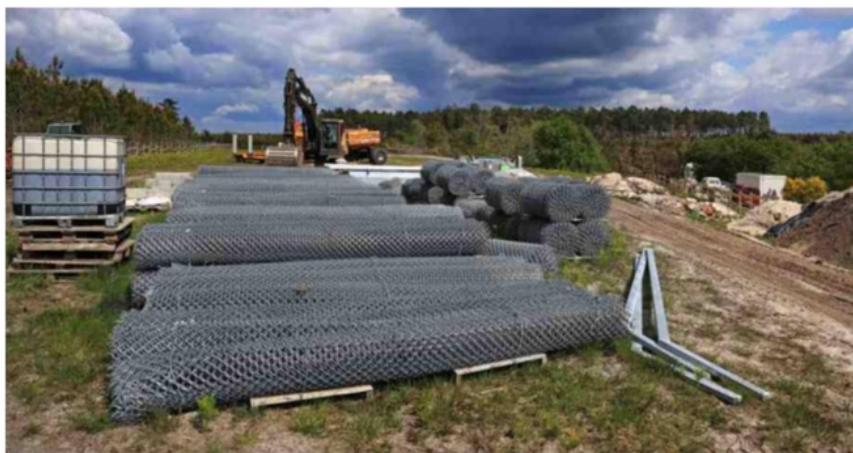
Les travaux ont démarré depuis plusieurs années sur le site de Mézos. PHILIPPE SALVAT / SO
