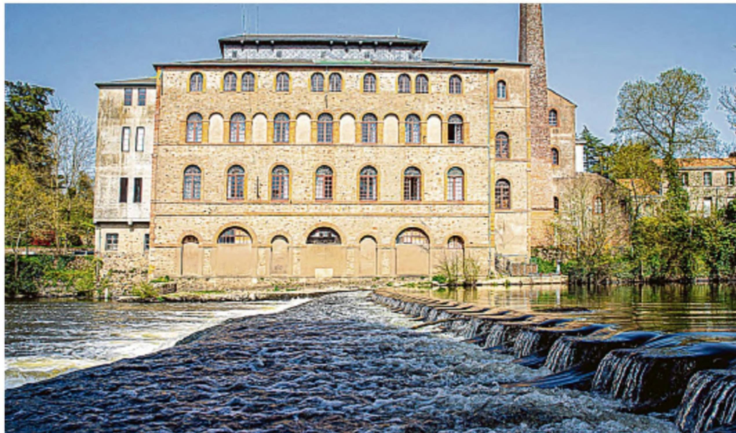
À Gorges (Loire-Atlantique), l'imposante filature d'Angreviers a été construite au début du XIX e en bordure de la Sèvre nantaise. Aujourd'hui, elle produit de l'électricité verte ! / PHOTO ELINA BARBEREAU, OUEST FRANCE
