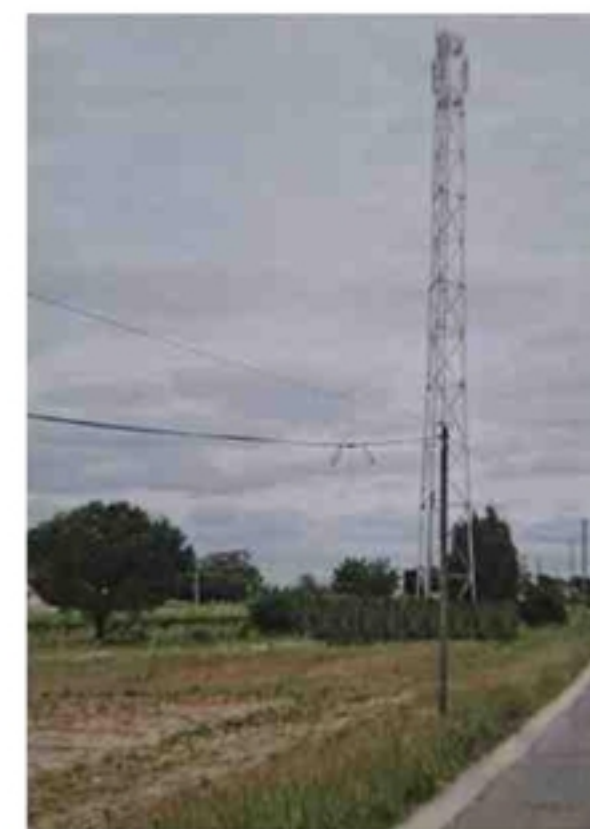
Le pylône choisi par TDF mesurera 36m de haut. Repro CL
