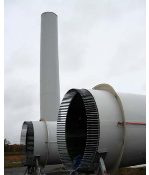
Une éolienne en cours d'installation en Haute-Vienne. Au 1er semestre 2025, le raccordement éolien a chuté en France. MG-LT
