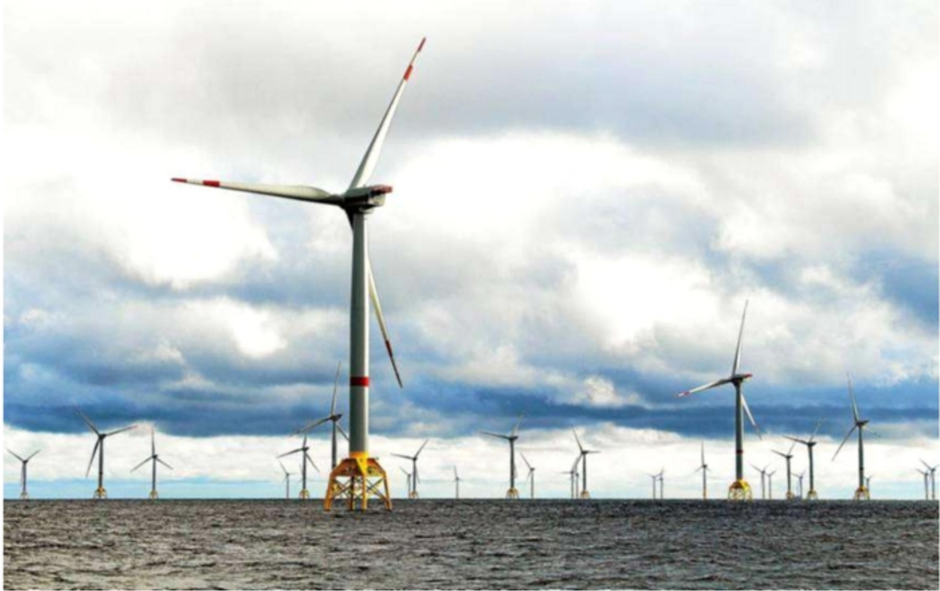
Les éoliennes offshore du parc allemand de Wikinger, en mer baltique, préfigurent ce que sera le parc éolien... Photo Julien Molla
